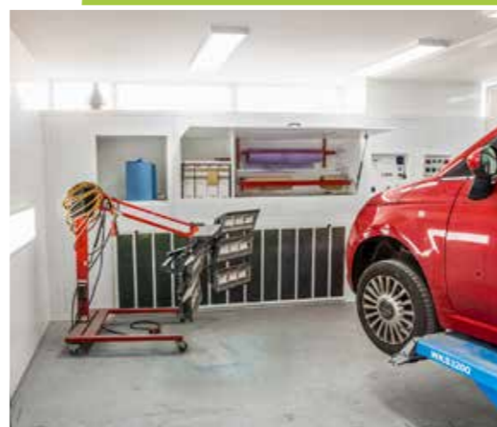
Autoschade Centrum Hilversum Foto: Merel Klijzing
