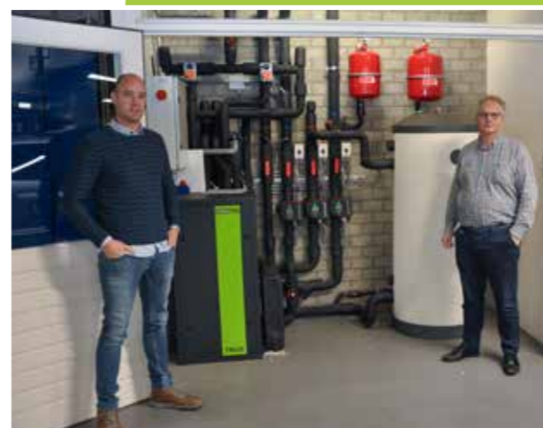
Arthur Sollman, operationeel manager installaties en Joop Mars, projectleider verduurzaming vastgoed
